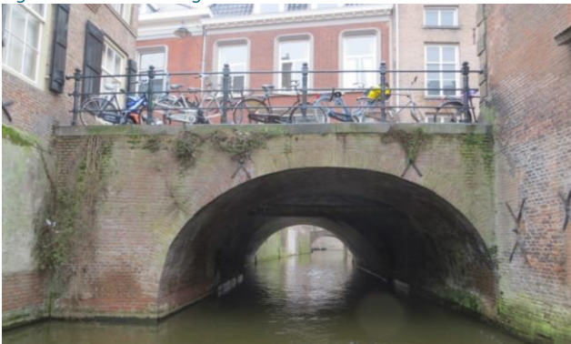
Figuur 2-1 Aanzicht brug Nieuwstraat van oost naar west
