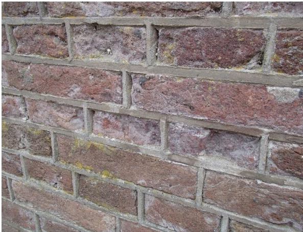
Figuur 10-5: Te harde voegmortel
