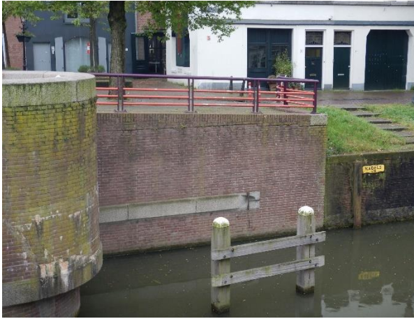
Figuur 10-7: Rollaag losgescheurd door stijfheidsverschil
