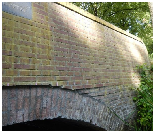
Figuur 10-23: Afschuiving borstwering en frontwand
