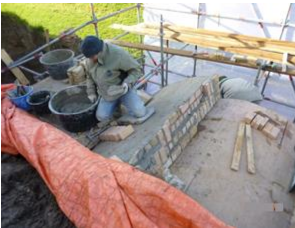
Figuur 10-13: Opbouw metselwerk gewelfboog op het formeel
