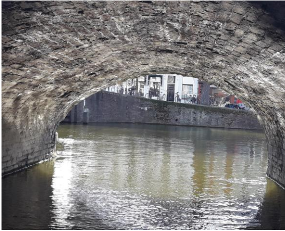
Figuur 10-19: Vervormde boog
