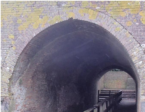
Figuur 10-9: Doorgaande scheur in gewelf
