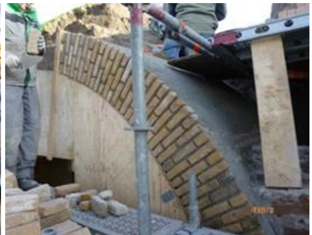
Figuur 10-14: Opbouw metselwerk gewelfboog op het formeel
