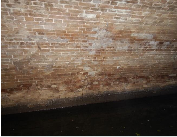
Figuur 10-1: Rond waterlijn uitgesleten voegen
